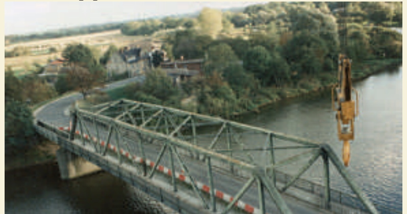
Die alte Brücke kurz vor dem Abriss.
