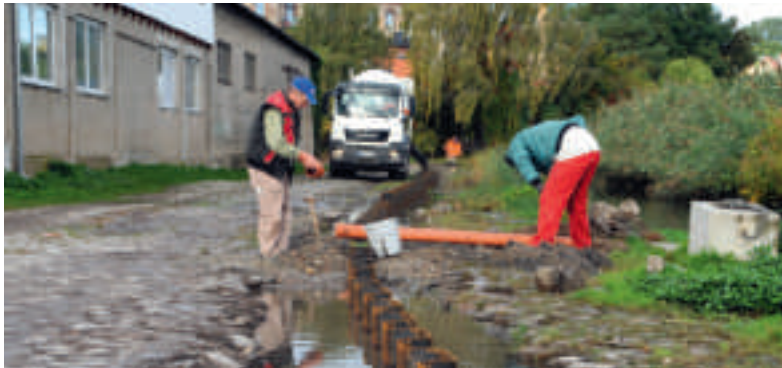
Zwischen Großer Fischerei und Bootshaus wird die Straße erhöht.
